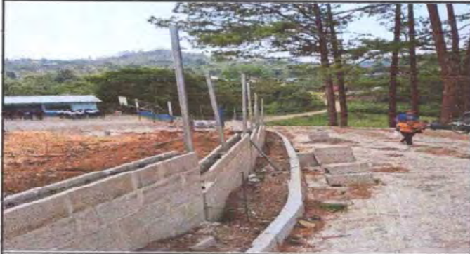
Foto 1: Continuación del muro perimetral que nos favorecera para el resguardo de los enseres, mobiliario y equipo con el que cuenta el centro educativo.
