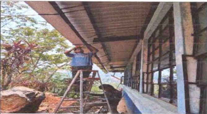
Foto 3: Desmontaje, limpieza e instalación de pescantes nuevos de canales galvanizados.
