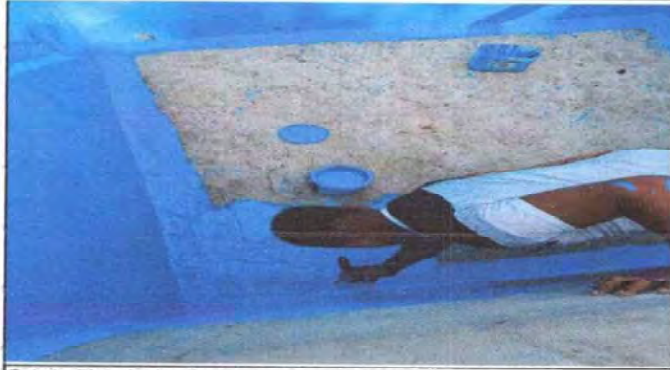
Foto 1: Pintado de pila de agua con pintura de piscina.
