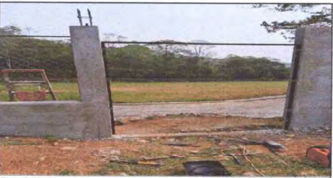
Foto 5: Instalación de porton en la primera entrada del muro perimetral.
