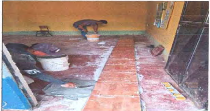
Foto 2: Colocación de piso cerámico en dos aulas, bodega y pasillo del modulo numero uno de la escuela.
